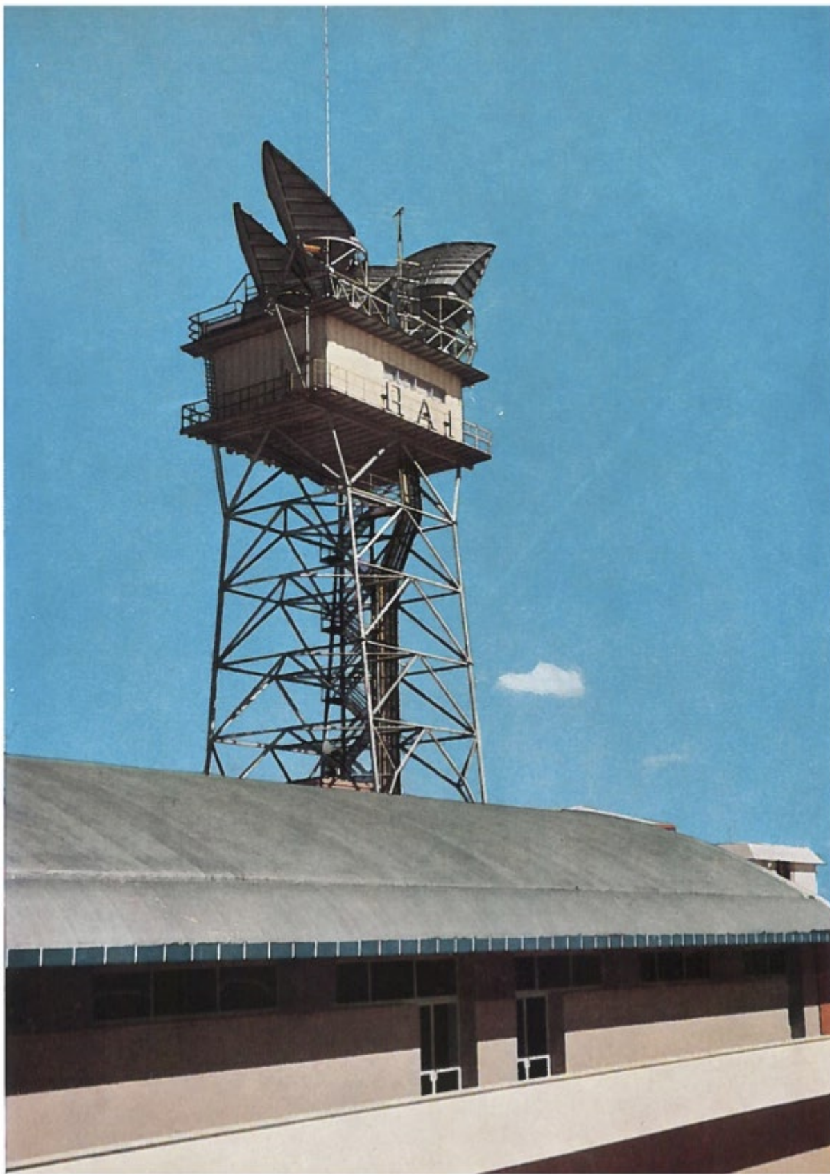
Torre ponti radio. Il Centro televisivo di Roma costituisce un punto nodale della rete italiana di ponti televisivi. Da qui partono i ponti video, audio e telefonici che uniscono Roma con Milano e Palermo.
