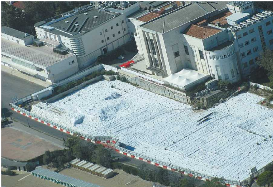
Una panoramica del cantiere del Palacinema. La voragine sarà coperta in tempo per l'inizio della Mostra del cinema
